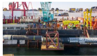
最終鋼管敷設完了 (2021年9月10日)
